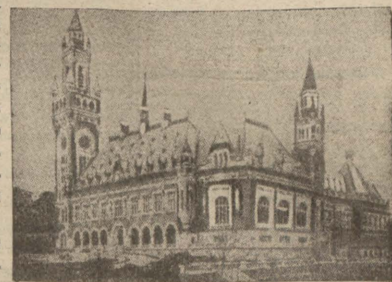
Beynelmilel adalet divanı binası
